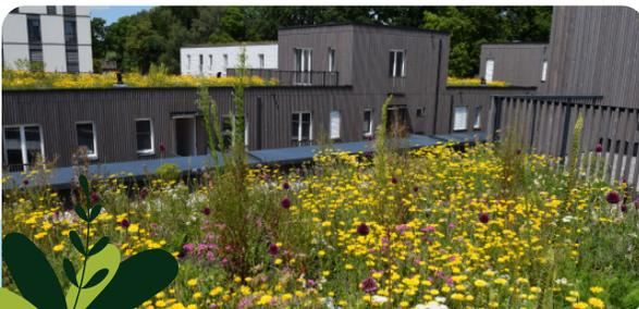
Durch Dachbegrünung ist die Dachabdichtung viel **geringeren Temperaturschwankungen** ausgesetzt (-5°C im Winter) bis +70°C im Sommer ohne Begrünung vs. 10°C im Winter bis +30°C im Sommer (mit Begrünung). **Dadurch hält sie im Schnitt 10-20 Jahre länger.**
