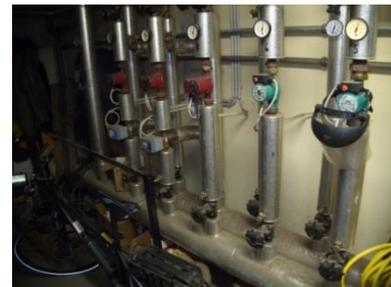
Die Wärmeabgabe an die konditionierten Räume erfolgt über Heizkörper mit Thermostatventilen. In den Hallen wird die Wärme über Aerothermen verteilt. Die Hallen werden über eine Thermostatregelung auf 17-18°C konditioniert. Die Brauchwasserbereitung erfolgt zentral über einen indirekt beheizten Warmwasserspeicher.
