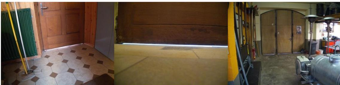
Die Eingangstür und die Tür auf der Rückseite des Gebäudes sind undicht. Der deutlich sichtbare Spalt unter der Tür führt zur Zugluft, wodurch Wärmeverluste entstehen. Ähnlich wie bei den Fenstern sind die Wärmeverluste relativ gering, jedoch ist der Verlust an Komfort und Behaglichkeit nicht zu vernachlässigen. Zudem schließt das Garagentor nicht dicht ab.
